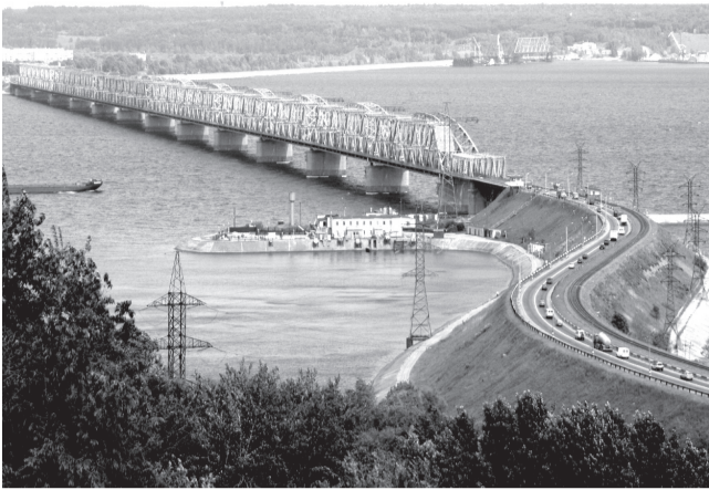
В связи с ремонтом деформационных швов с полуночи до 4 часов утра 25 октября и 1 ноября будет перекрыто движение транспортных средств по Императорскому мосту через реку Волга.
